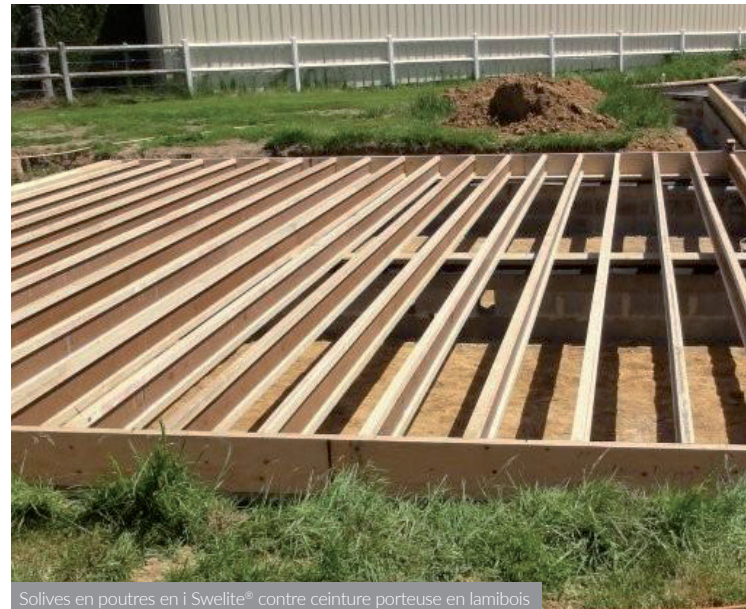
Solives en poutres en i Swelite® contre ceinture porteuse en lamibois
