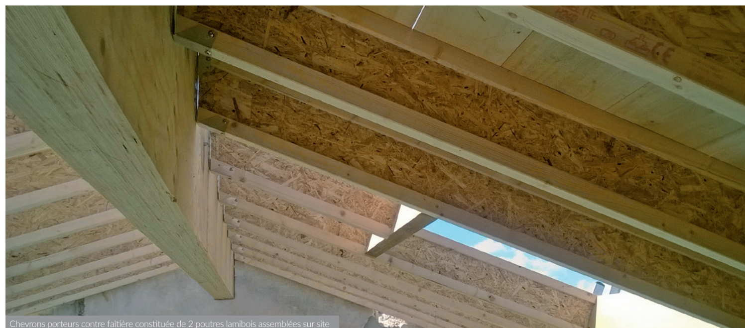
Chevrans porteurs contre faîtière constituée de 2 poutres lamibois assemblées sur site
