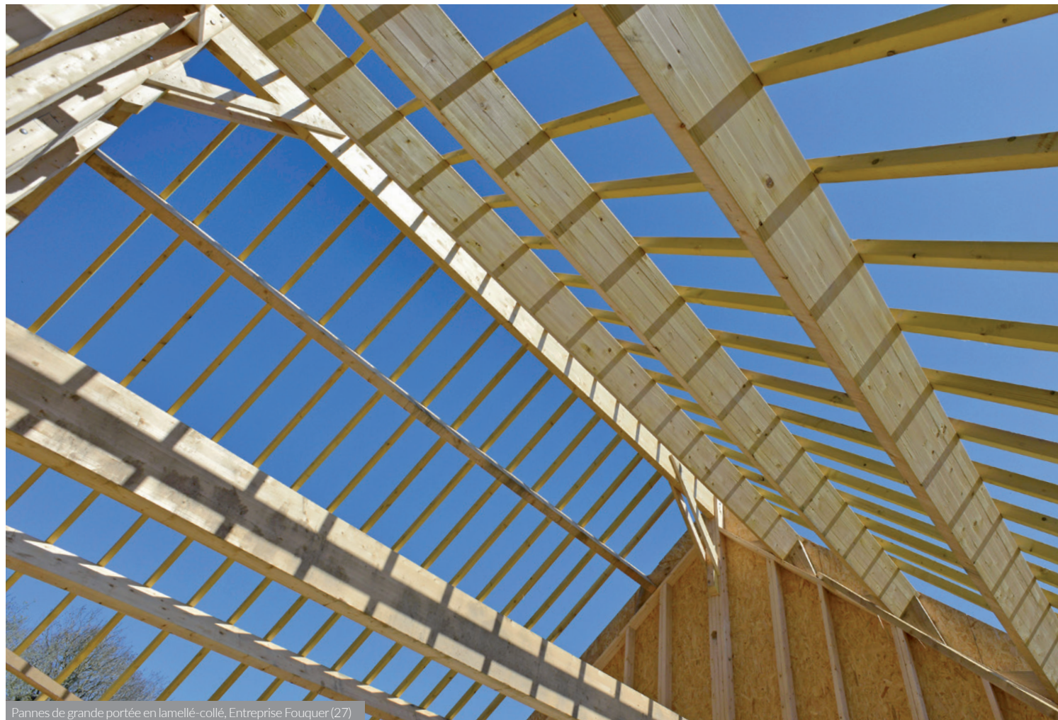
Pannes de grande portée en lamellé-collé, Entreprise Fouquier (27)
