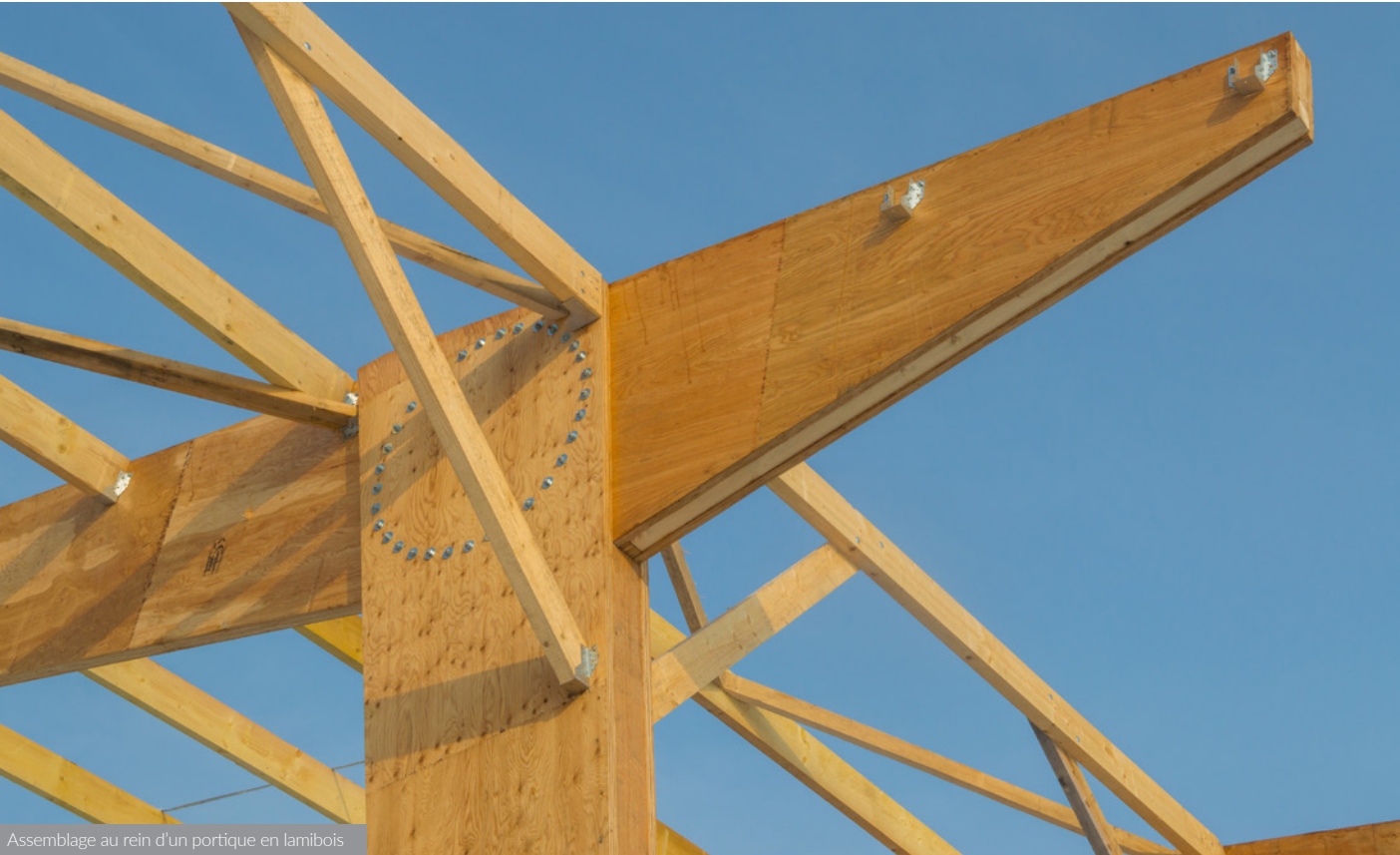
Assemblage au rein d'un portique en lamibois
