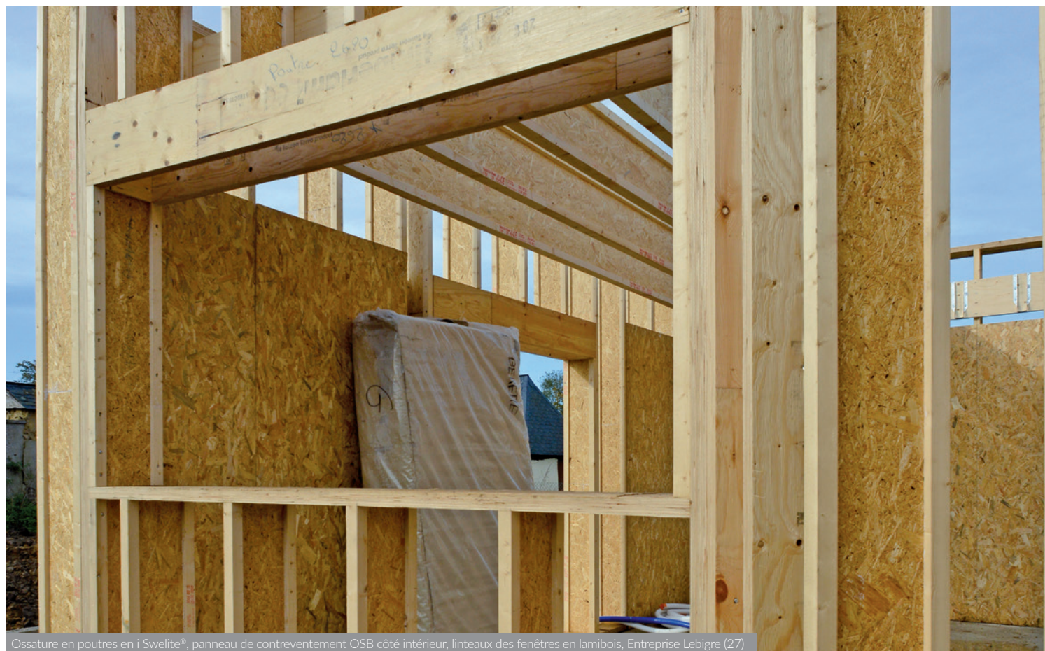
Ossature en poutres en i Swelite®, panneau de contreventement OSB côté intérieur, linteaux des fenêtres en lamibois, Entreprise Lebigre (27)
