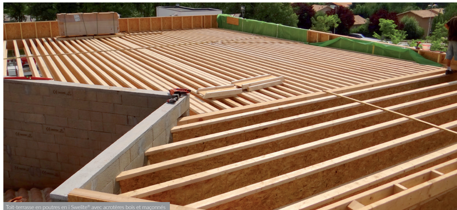
Toit-terrasse en poutres en i Swelite® avec acrotères bois et maçonnés
