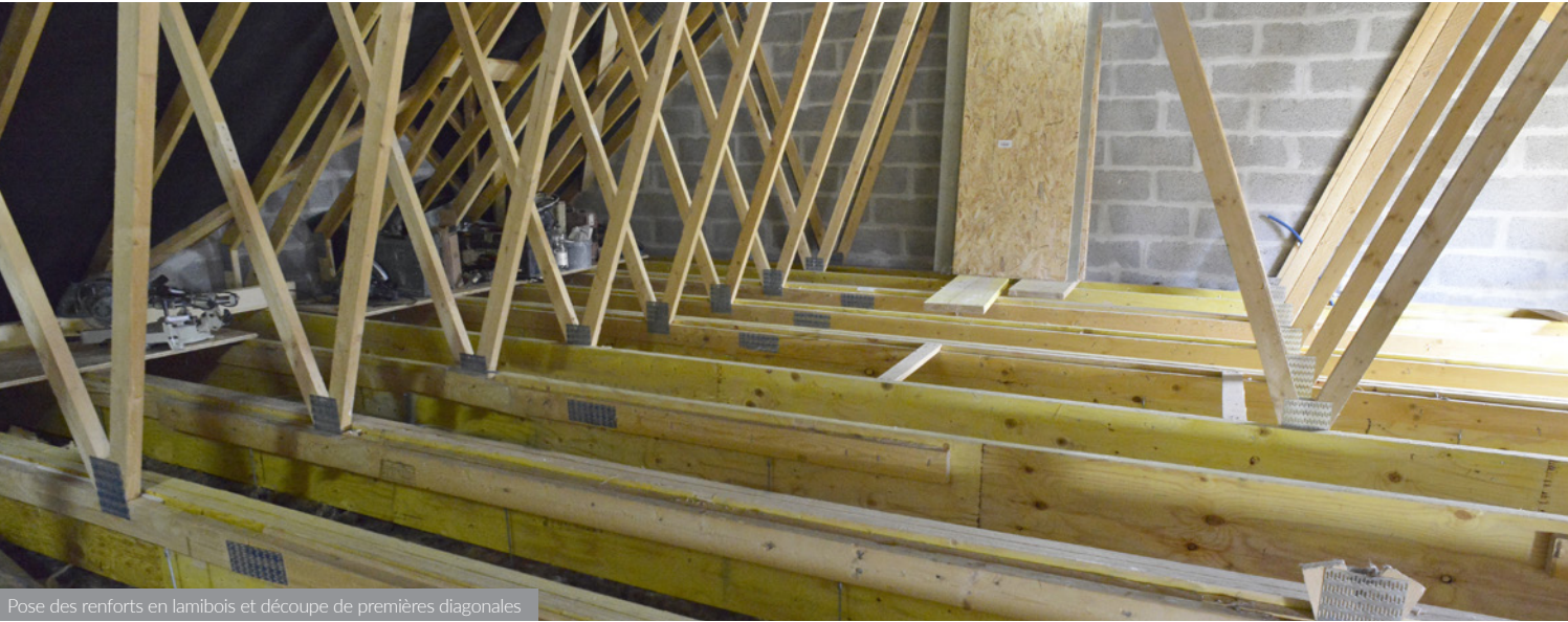
Pose des renforts en lamibois et découpe de premières diagonales
